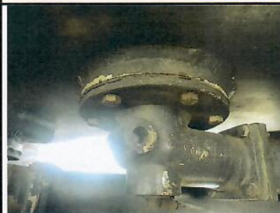
Détail clapet de fond
