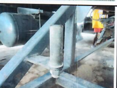
Exemple Borne de liaison équipotentielle
