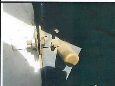
Exemple Borne de liaison équipotentielle
