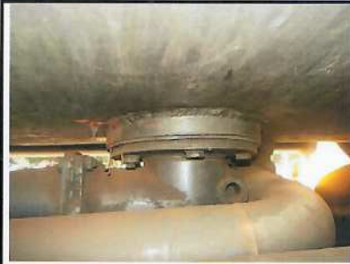
Détail clapet de fond
