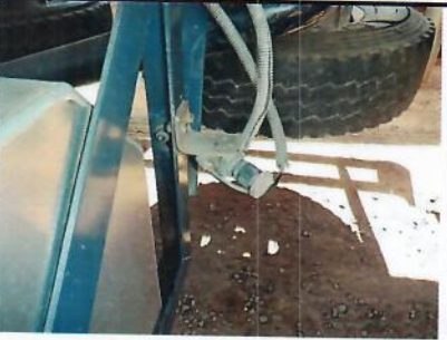
Arrêt d'urgence clapet de fond
