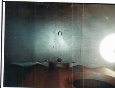
Détail intérieur dans Cpt n°3
