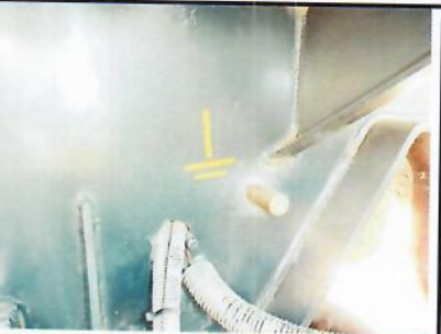
Exemple borne de liaison équipotentielle La valeur mesurée est de 2.25 Ω.
