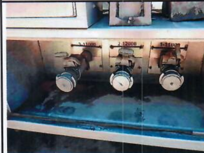
Détail vannes de dépotage
