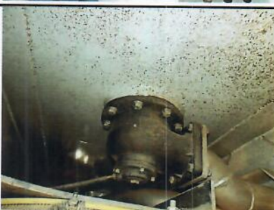
Détail clapet de fond
