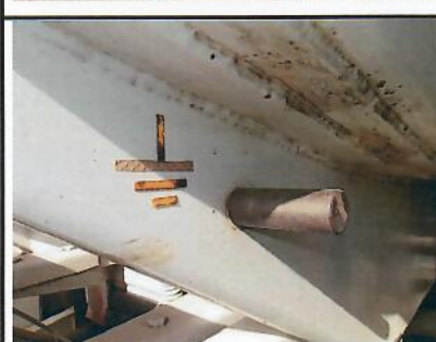
Exemple Borne de liaison équipotentielle
