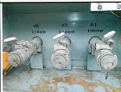
Détail vannes de dépotage
