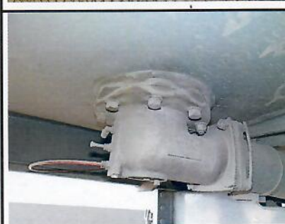
Détail clapet de fond
