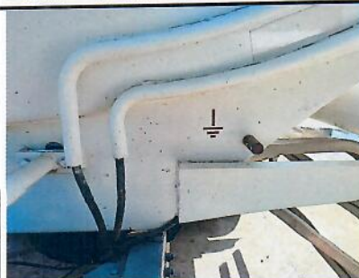
Exemple Borne de liaison équipotentielle
