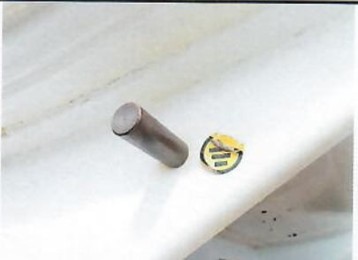
Exemple Borne de liaison équipotentielle
