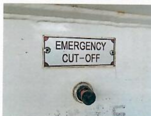
Commande d'arrêt d'urgence
