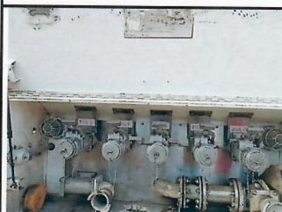
Détail vannes de dépotage
