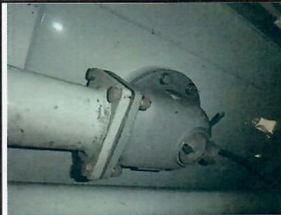
Détail clapet de fond
