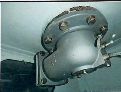
Détail clapet de fond
