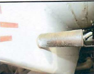
Exemple Borne de liaison équipotentielle
