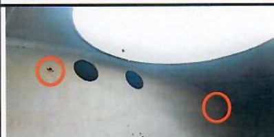
Détail intérieur n°5 Brise flot non étanche
