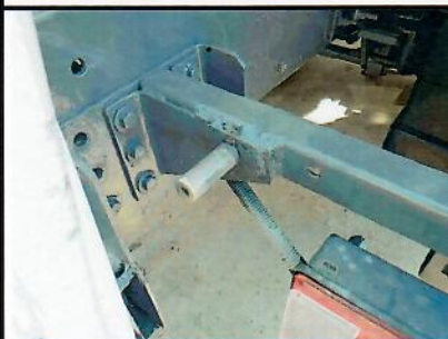
Exemple Borne de liaison équipotentielle
