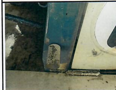
Exemple Borne de liaison équipotentielle
