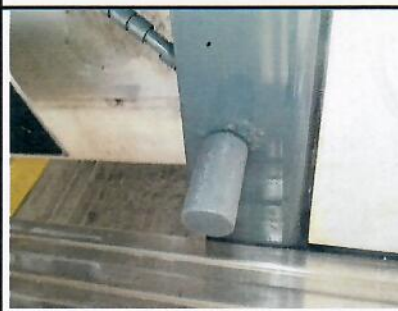
Exemple Borne de liaison équipotentielle
