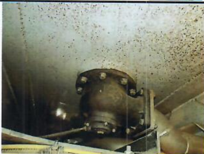
Détail clapet de fond
