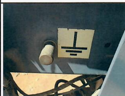
Exemple Borne de liaison équipotentielle
