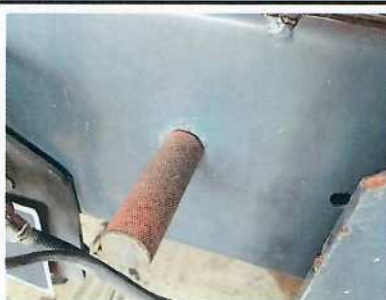
Exemple Borne de liaison équipotentielle
