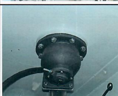
Détail clapet de fond
