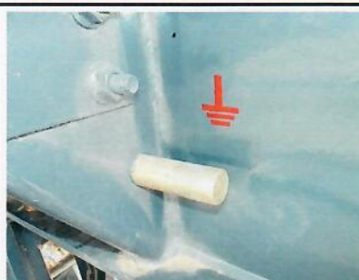
Exemple Borne de liaison équipotentielle
