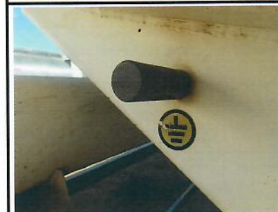
Exemple Borne de liaison équipotentielle
