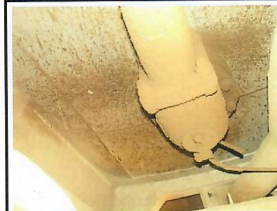
Détail clapet de fond
