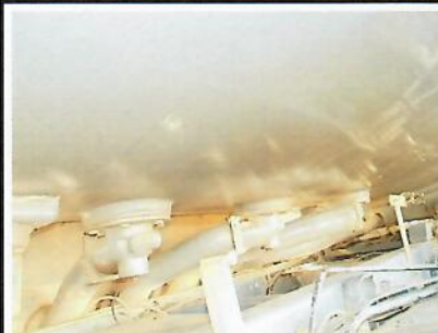
Détail clapet de fond
