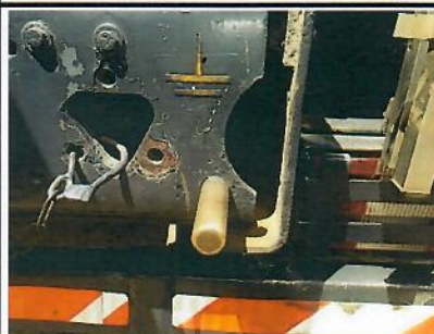
Exemple Borne de liaison équipotentielle
