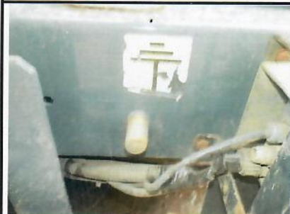
Exemple Borne de liaison équipotentielle
