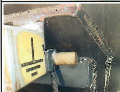
Exemple Borne de liaison équipotentielle
