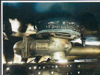
Détail clapet de fond
