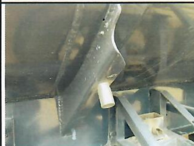
Exemple Borne de liaison équipotentielle
