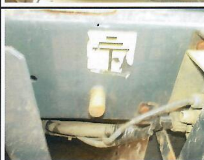
Exemple Borne de liaison équipotentielle
